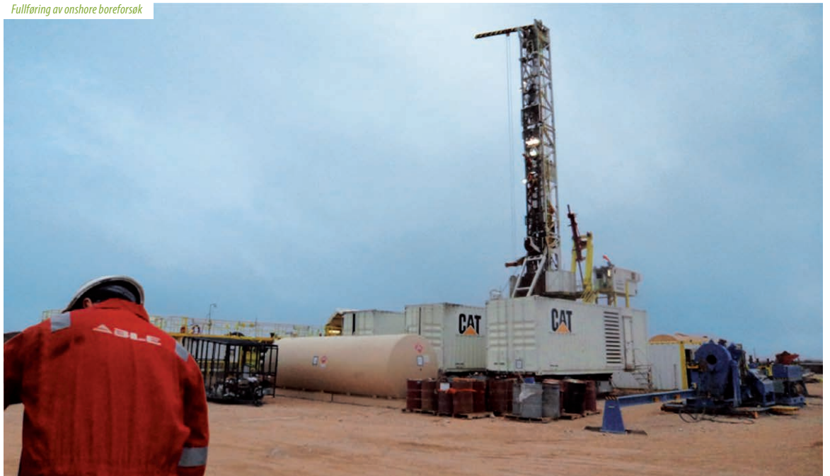
Fullføring av onshore boreforsøk
